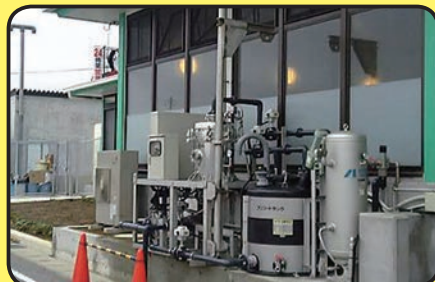
浴槽水：20m 3 /hr モノ MAX ユニット 450A
